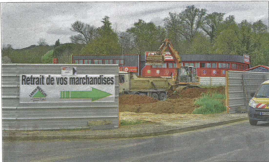
Actuellement, la première phase des travaux d'agrandissement du Leroy Merlin concerne la création d'une nouvelle cour matériaux. PHOTO JACQUES CHAUNAVEL
